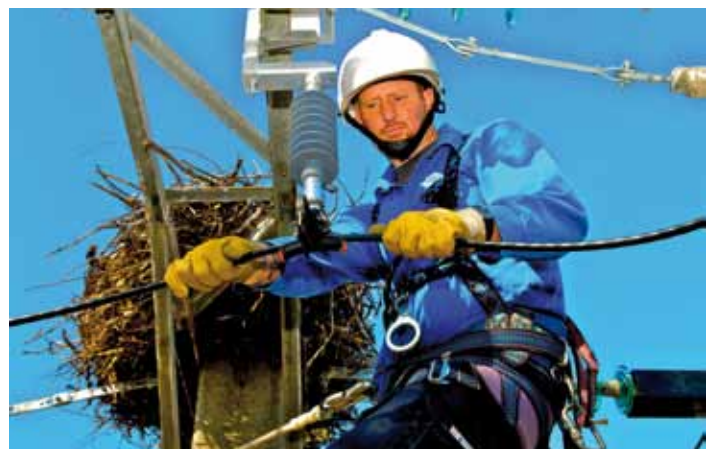
Installation de protections avifaunes afin d'éviter tout risque d'électrocution d'un couple de cigognes : pose d'un renvoi de pont par un agent ERDF.
