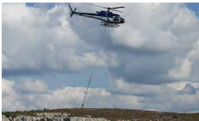
Pose de lignes aériennes pour le lancement de l'opération d'enfouissement de 6 km de lignes électriques enfouies au cirque de Navacelles hélitreuillage d'un pylône.
